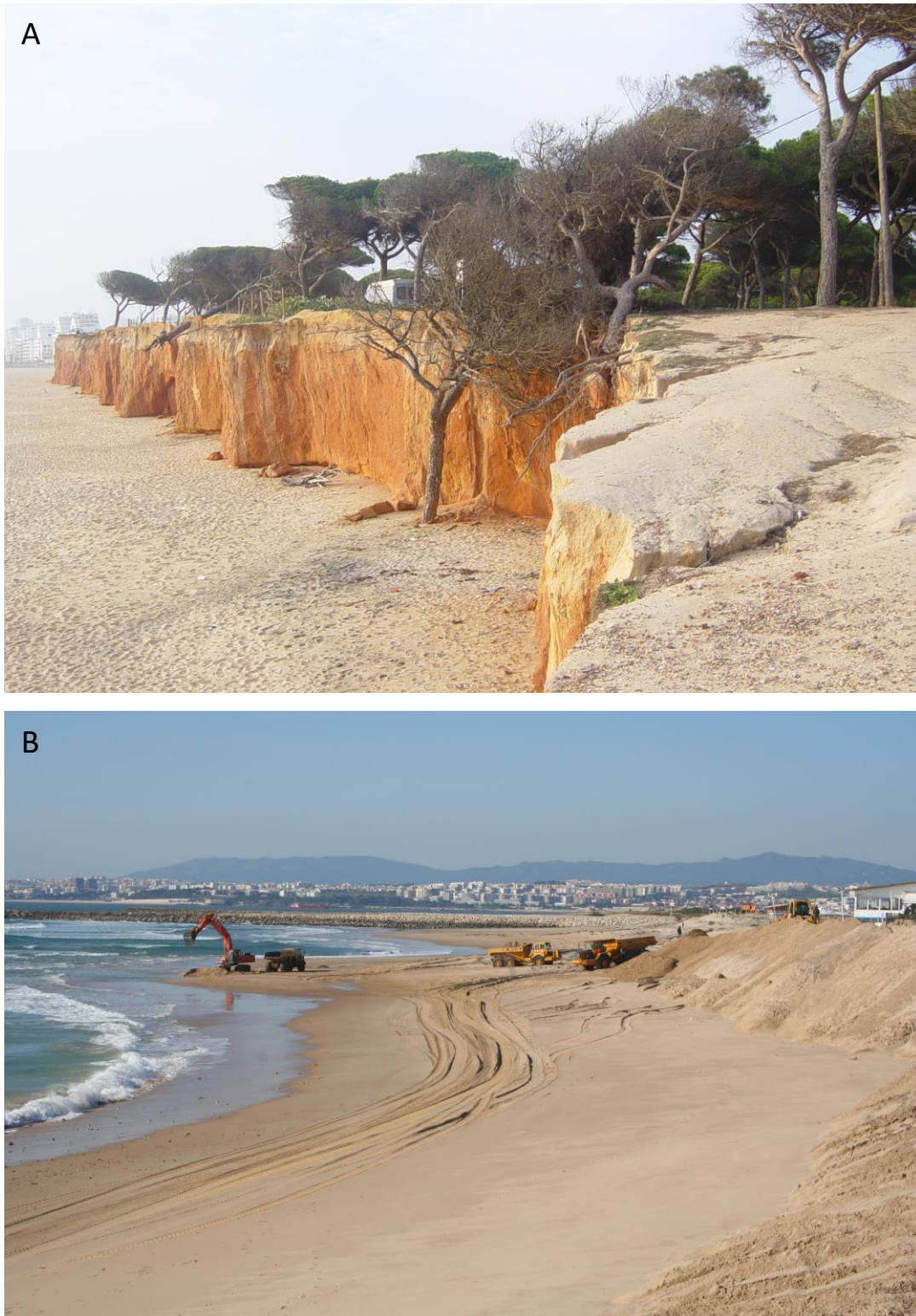
Fig. 16. Erosión costera en acantilados y costas arenosas. A) Sector costero de Trafal (este de Quarteira) con acantilados excavados en sedimentos de Plio-Pleistoceno poco consolidados); B) Realimentación artificial de playa, Costa da Caparica, enero de 2007.
