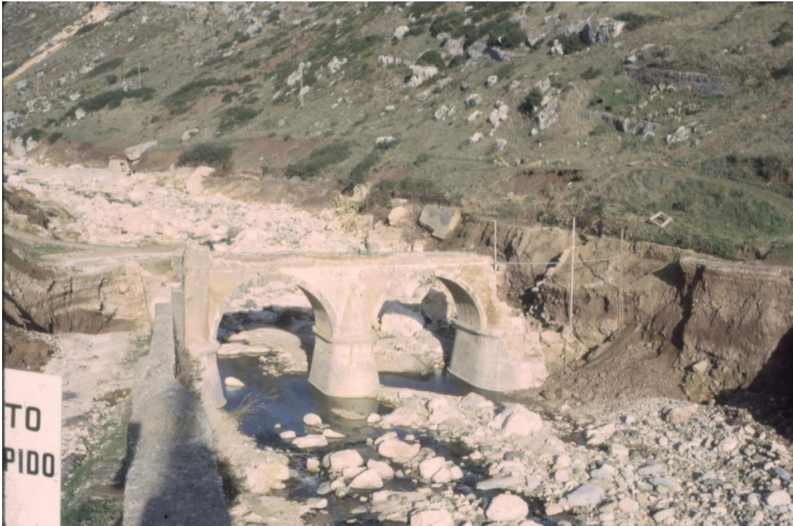
Fig. 3. Puente destruido por la inundación rápida de 1967 en el valle de Trancão (norte de Lisboa).
